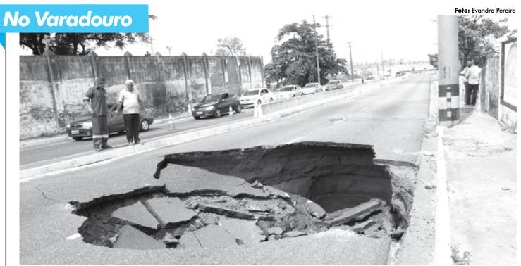
De acordo com a Cagepa, que iniciou ontem o conserto, a tubulação deve ter rompido em razão dos veículos de cargas que trasitam constantemente no local
